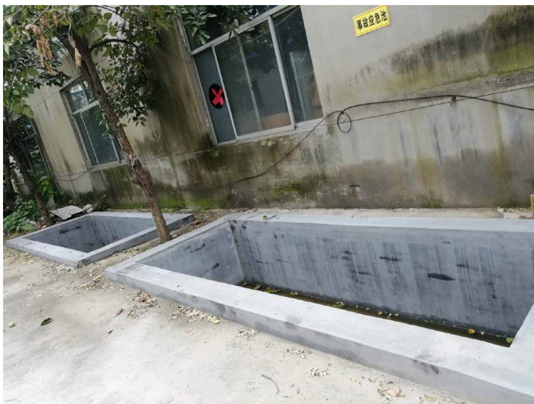
图 14 应急事故水池
