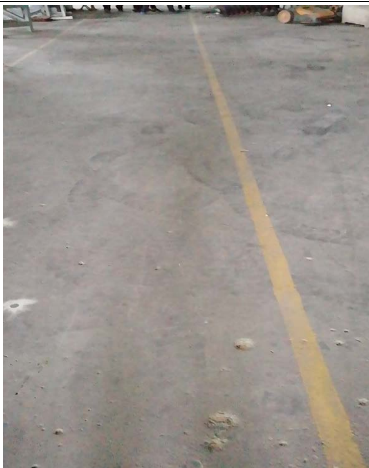
图 13 厂区地面硬化
